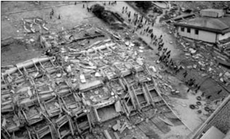
图1-9 被爆破的旧厂房
