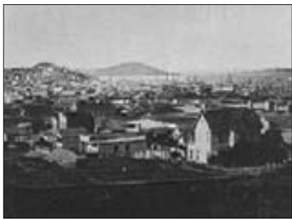
图1-23 改造前的叶巴·贝那中心
