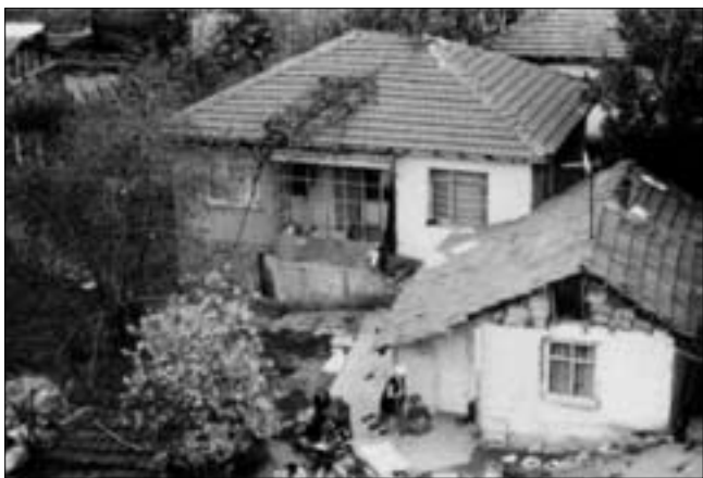
图1-38 无主土地上修建的住房
